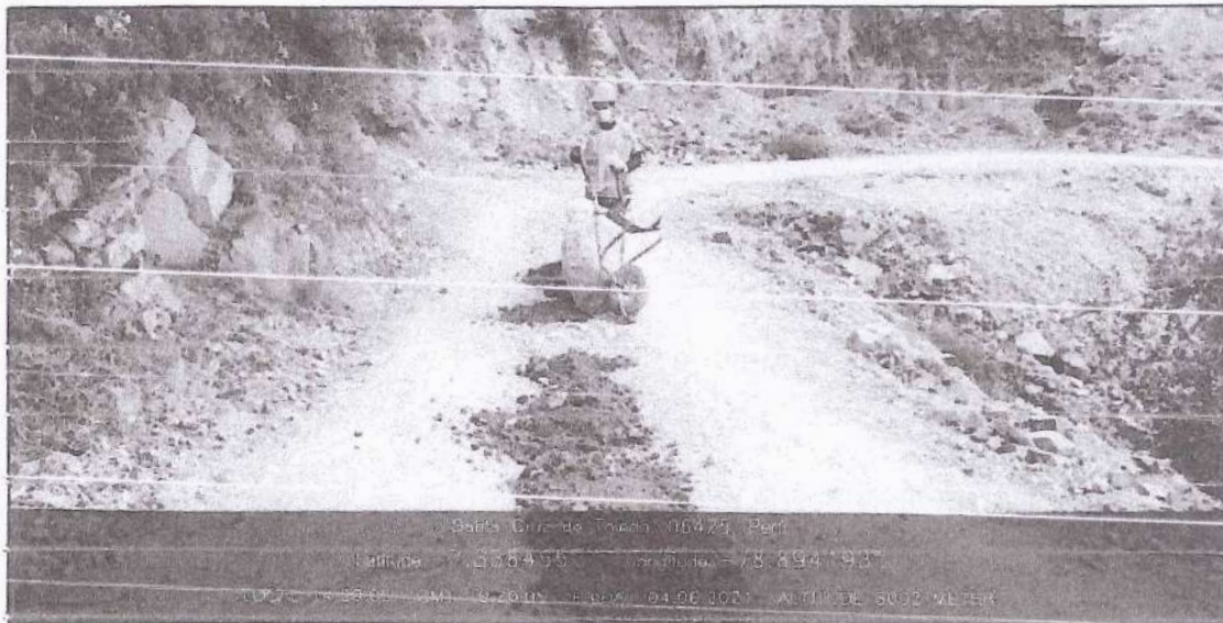
FOTO N° 10: Se puede observar la ejecución de la partida de bacheo (durante).
