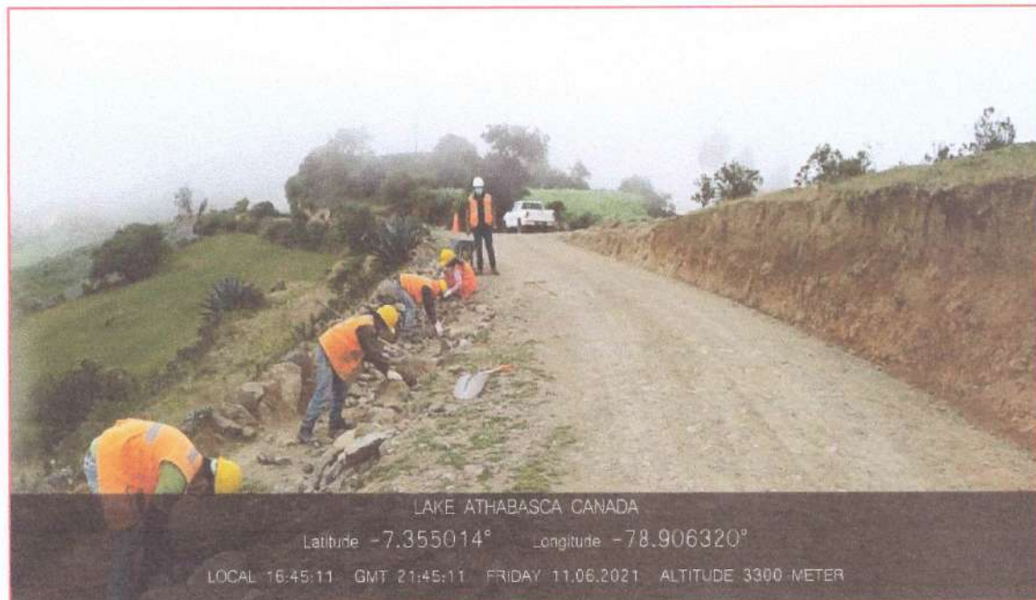
FOTO N° 02: En la imagen se observa la elaboración de un muro seco, para así aumentar el ancho de calzada y la estabilidad para dar una buena transitabilidad.
