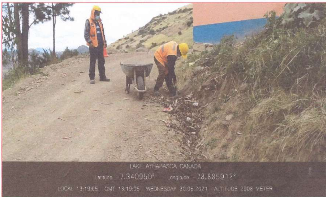
FOTO N° 17: En la imagen se observa la limpieza de los matorrales que cubren la cuneta.
