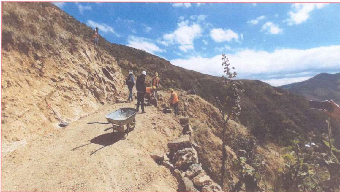
FOTO N° 04: En la imagen se observa realizando los trabajos de un muro seco, para así aumentar el ancho de calzada para dar una buena transitabilidad.
